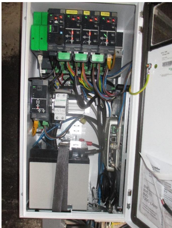
SLIKA 4 – TK OPREMA NA TRAFU STANICI
